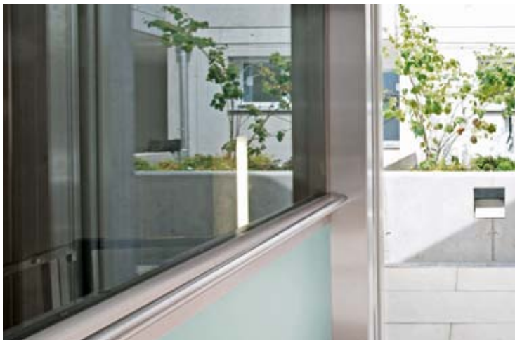
Edelstahl-Handlauf und Kabinenfenster talseitig
